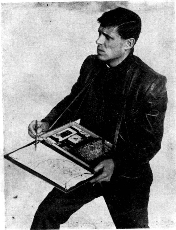
Fot. 3. Przenośny stół do fotointerpretacji polowej TO-POPRET VEB Zeiss Jena
