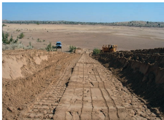
Ryc. 4. Buldożery przygotowujące podjazd pod wydmy. Fig. 4. Bulldozers cutting route lines across sand dunes.
