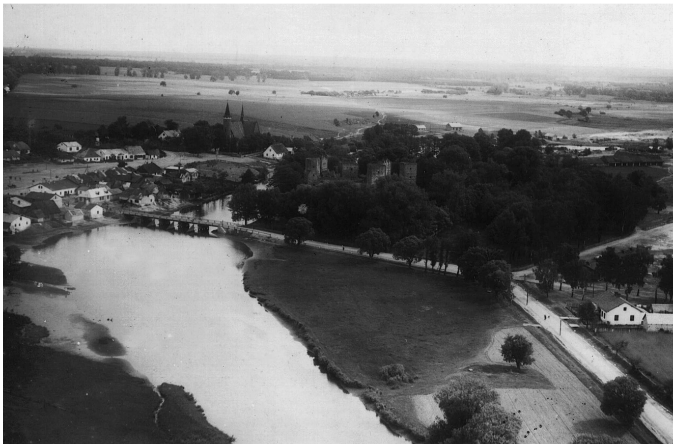
Ryc. 17. Drzewica. A. B. Peszke, fotografia wykonana w latach 1929-1933. Fig. 17. Drzewica. Photograph taken by A. B. Peszke in 1929-1933.
